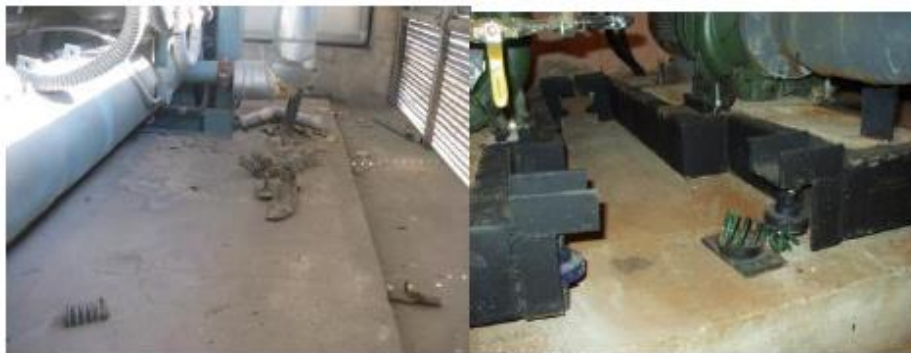
شکل (۳): چپ: لرزه گیرهای گوشه ای زیر چیلر کاملاً از محل خود خارج شده اند و چیلر سقوط کرده است. راست: اختلال سیستم لرزه گیر پمپ دارای اینرشیا بیس به دلیل فقدان مهار کننده فنر.
