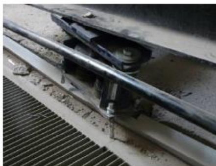
شکل (۴): لرزه گیر سالم است اما بتن به دلیل نزدیک بودن بیش از حد انکر بولت به لبه آن تخریب شده است.
